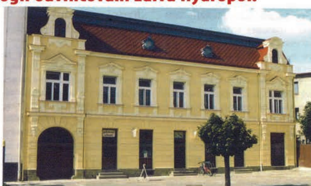
Obr. 2 Objekt po sanaci vlhkého zdiva
