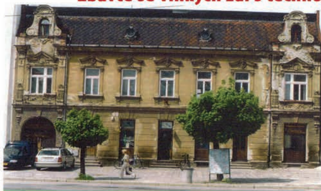
Obr. 1 Objekt před sanací vlhkého zdiva
