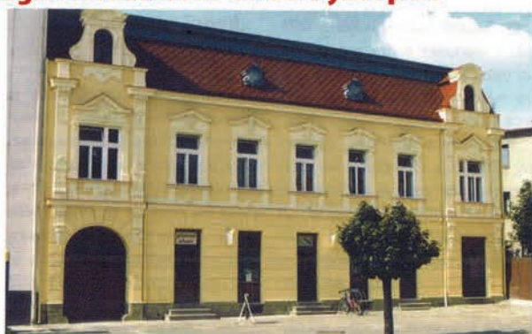
Obr. 2 Objekt po sanaci vlhkého zdiva
