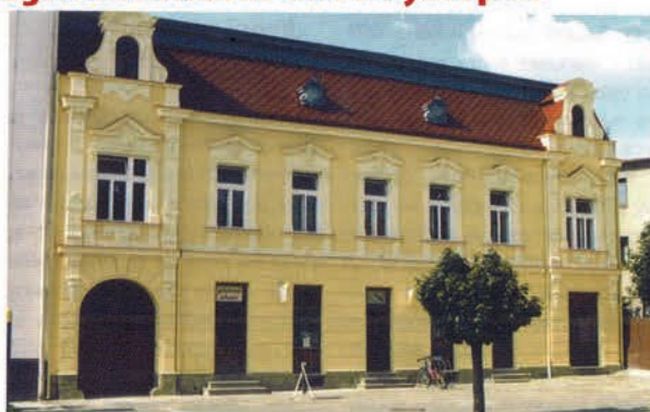
Obr. 2 Objekt po sanaci vlhkého zdiva
