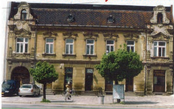
Obr. 1 Objekt před sanací vlhkého zdiva
