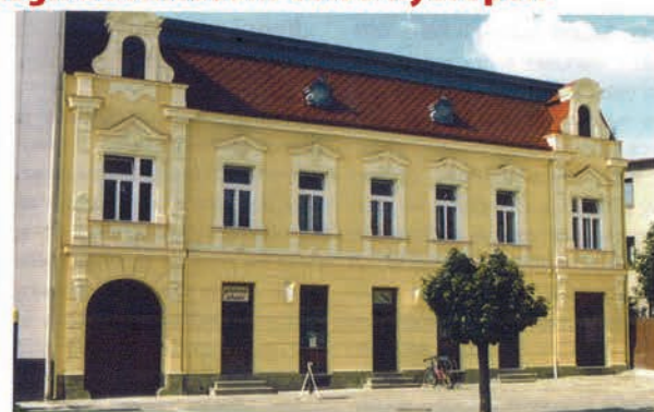
Obr. 2 Objekt po sanaci vlhkého zdiva
