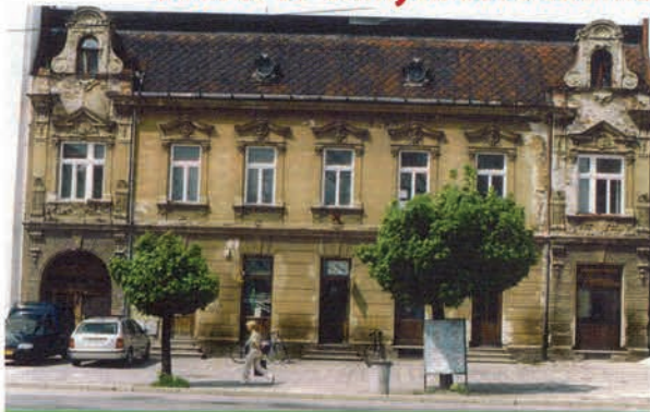
Obr. 1 Objekt před sanací vlhkého zdiva
